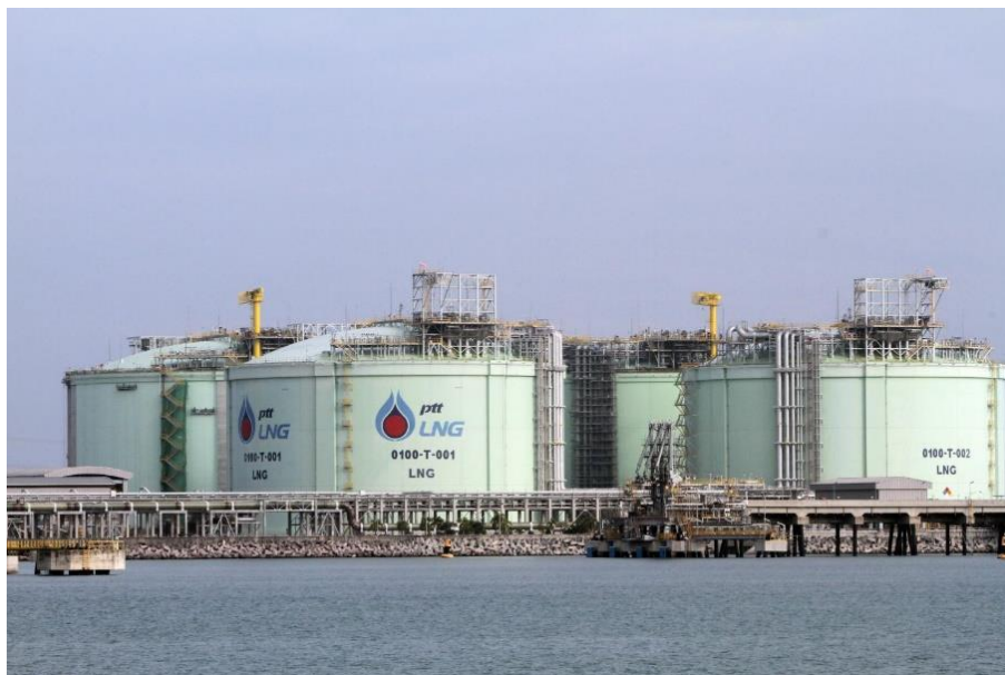
รูปที่ 20 Fully Refrigerated Storage Tanks
