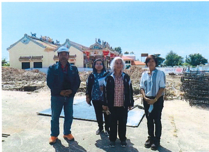
อุดหนุนมูลนิธิเกาะโพธิ์โพธิญาณ ตำบลท่าบุงญี่ อำเภอเกาะจันทร์ โครงการก่อสร้างอาคารอเนกประสงค์ งบประมาณ 14,000,000 บาท โครงการอยู่ในระดับความสำเร็จ
