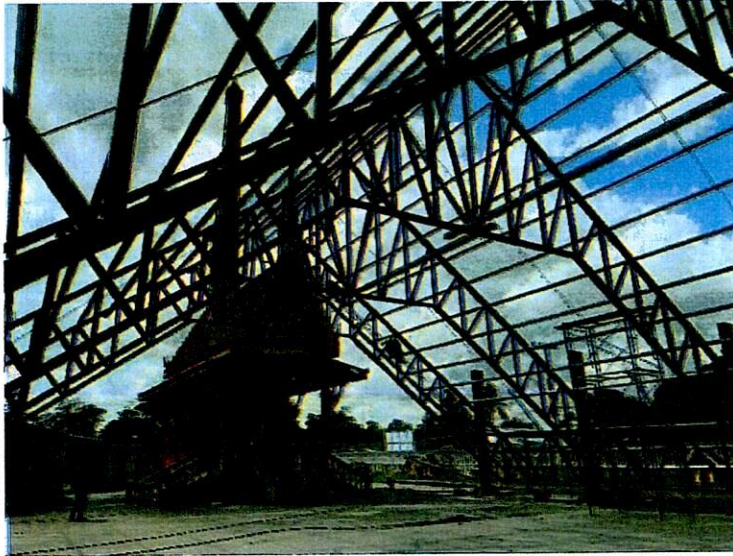
อุดหนุนวัดท่าบุญมี ตำบลท่าบุญมี อำเภอกะเจ็ญจันทร โครงการก่อสร้างศาลาอเนกประสงค์ งบประมาณ 1,000,000 บาท โครงการอยู่ระหว่างดำเนินการ
