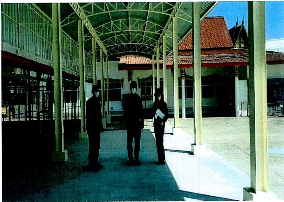
อุดหนุนวัดหนองใหญ่ ตำบลนาเกลือ อำเภอบางละมุง โครงการบูรณะศาลาการเปรียญ งบประมาณ 1,000,000 บาท โครงการดำเนินการแล้วเสร็จ
