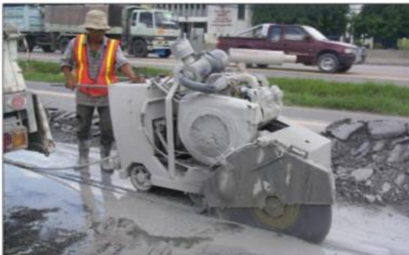
รูปที่ 2.4-6 การเลื่อยตัดแผ่นคอนกรีต
