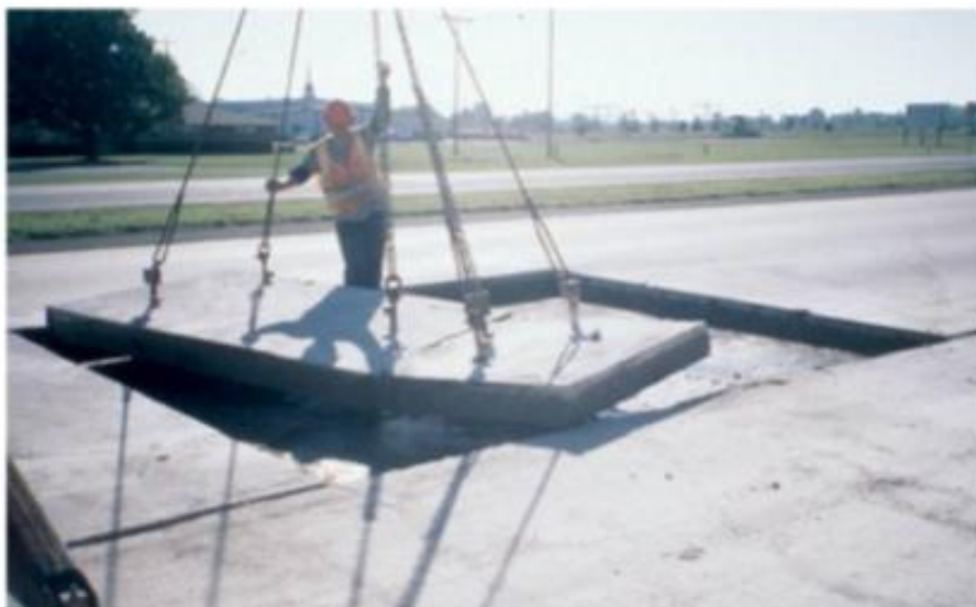
รูปที่ 2.4-8 การรื้อแผ่นคอนกรีตโดยวิธีการยกแผ่นคอนกรีตออก (Lift – out Method)
