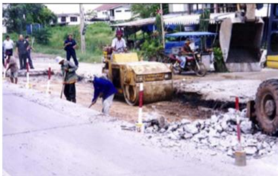
รูปที่ 2.4-9 การปรับปรุงชั้นพื้นทางใต้แผ่นคอนกรีตเดิม
