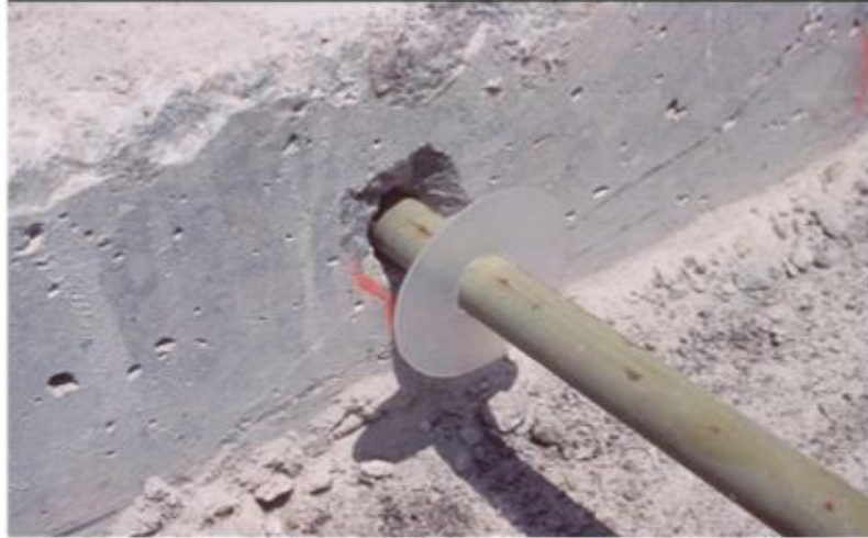
รูปที่ 2.4-11 การติดตั้งแหวนยางเพื่อป้องกันน้ำปูนไหลเข้าไปในปลอกเหล็กเดียว
