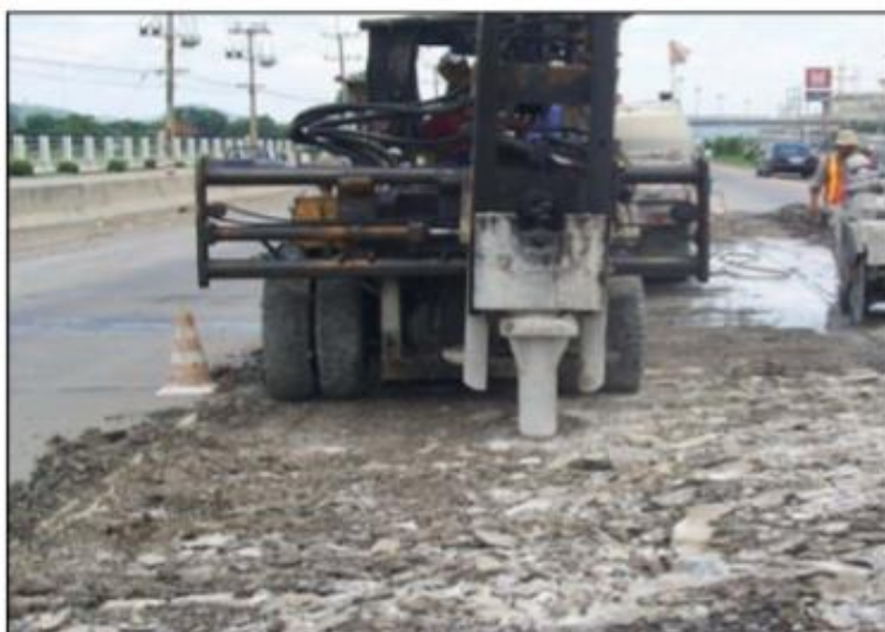
รูปที่ 2.4-7 การรื้อแผ่นคอนกรีตโดยวิธี ทุบให้แตกแล้วรื้อออก (Breakup and Clean – out Method)
